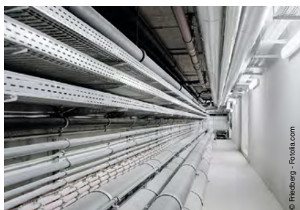
Bevestiging van kabelschachten
