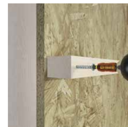
Bevestiging van regelwerk t.b.v. installaties
